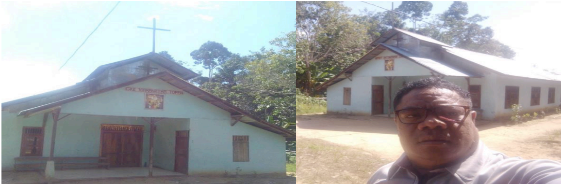
Bangunan Gereja GKE Maranatha Topan Ketua Resort GKE Nanga Tebidah Pdt. Osias Kause
